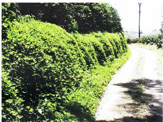
Protección de taludes empleando maní forrajero
