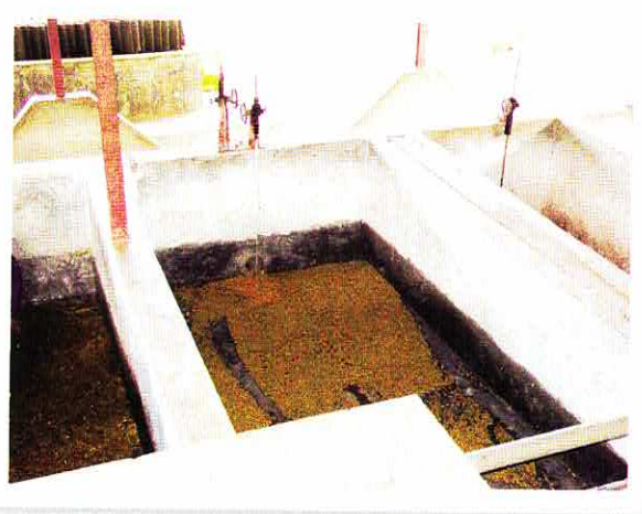
Tanques de fermentación
