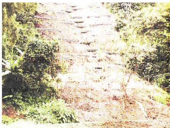
Prevención de erosión con manejo de empalizadas en guadua
