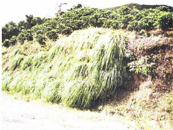
Protección de taludes usando Lantana
