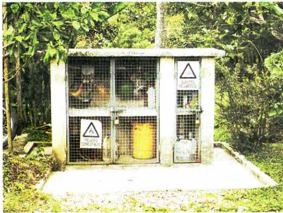
Ejemplo de bodega de almacenamiento en pequeña escala. Con puerta cerrada y ventilación.
